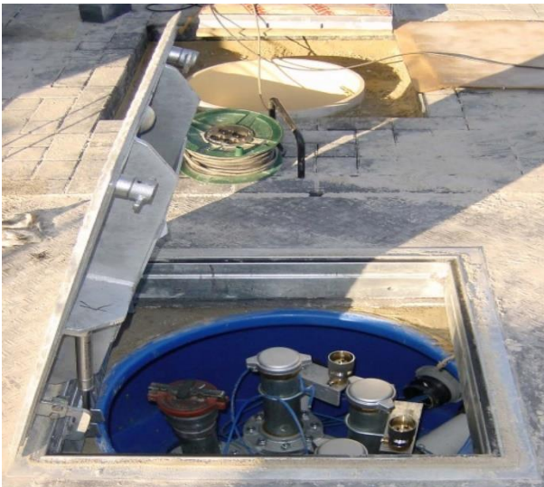
Kraftig betäckning godkänd upp till 25 tons trafiklast. Kan också levereras för upp till 40 tons trafiklast.
