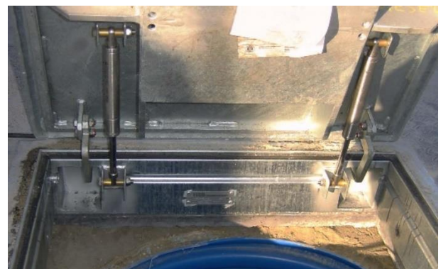
Stabila gångjärn och 2 stycken gas fjädring ger lätt öppning och lång livstid.
