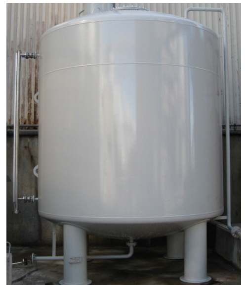
20 m 3 vertikal tank til svovlsyre inkl. tørrepotte, niveauiser, rustfrie ventiler m.m.
