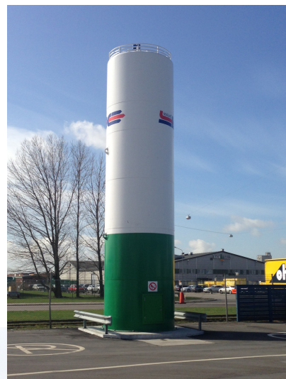
Vertikal tank på 60 m 3 diameter 2900 mm
