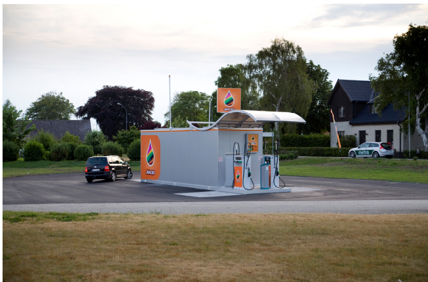
Tankanlæg til diesel og benzin med en indbygget 30 m 3 dobbeltvægget tank delt i to rum.
